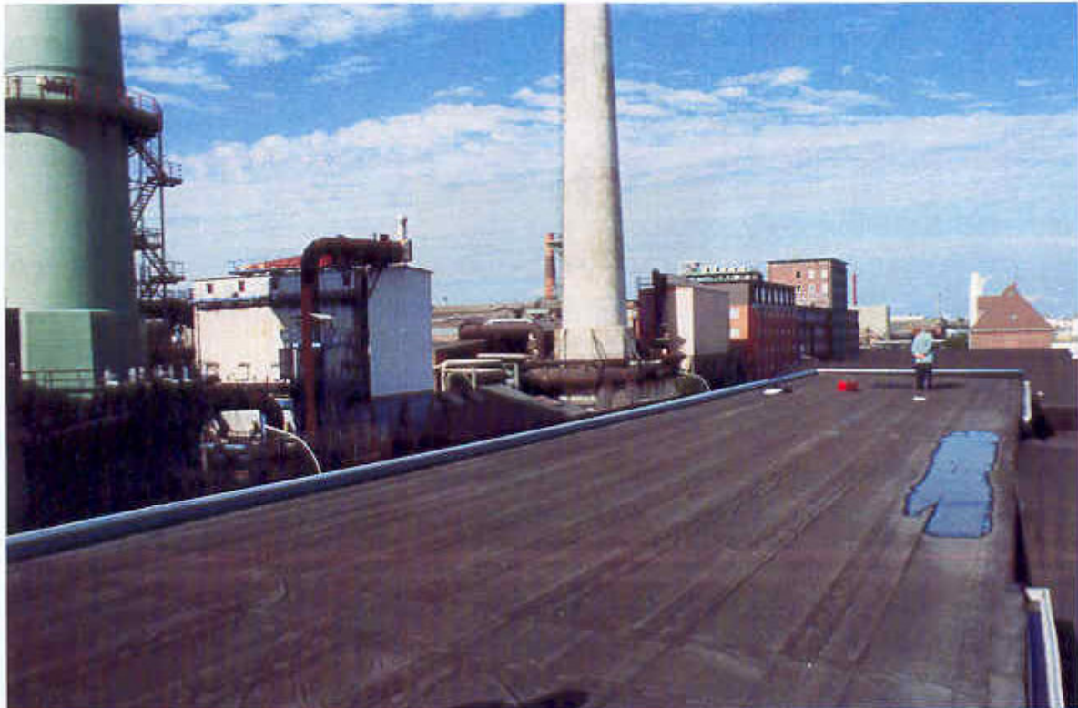
Fig. 1: Examination of the roof surface of BV „HH-Veddel, Industriegebäude“
